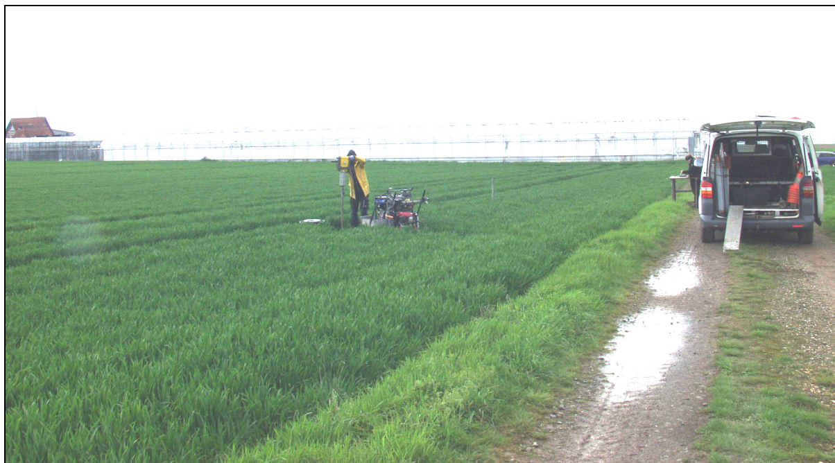
Abb. 2: Untersuchungsbereich; Arbeiten zu Pilotbohrung „RKS 1“ (Blick nach Nordwesten)
